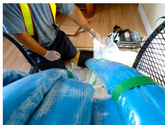
fuient, les infiltrations d'eau ainsi que l'intrusion des racines dans les tuyaux d'égouts. Les produits utilisés donnent un conduit relativement mince et solide ayant une durée de vie de 50 ans et plus. Cette technologie permet d'effectuer les réparations peu importe les conditions climatiques extérieures.
