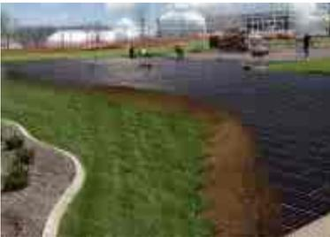
Les pavés végétaux sont des grilles de plastique que l'on dépose sous l'herbe, et qui en protègent les racines au passage d'un véhicule.
